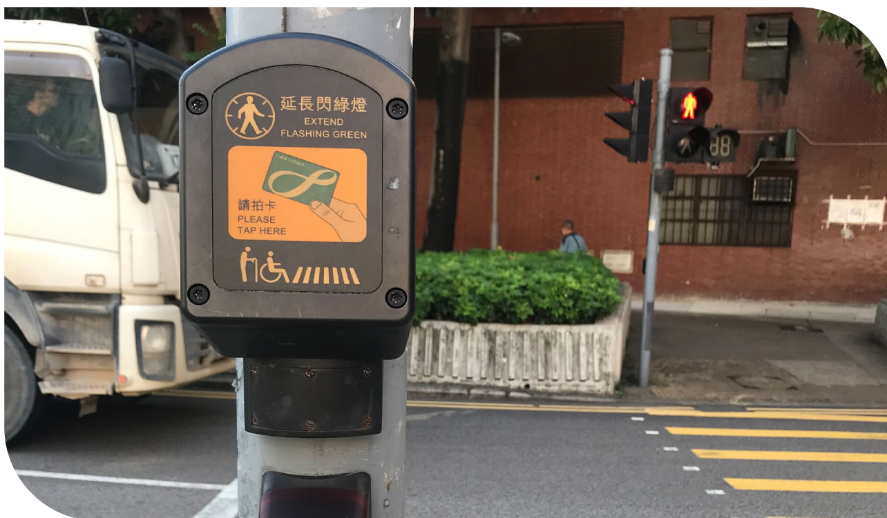
位於九龍城區(溫思勞街)延長行人閃動綠燈的智能裝置
