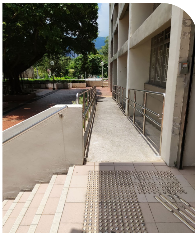
廣福社區會堂設有無障礙設施
