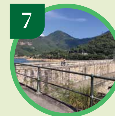
7 「大潭上水塘水壩」上的風景。
